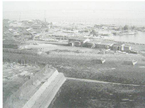
写真6 整備工事中の宇部漁港 〔昭和12年事業着手、昭和14年竣工〕 「宇部漁港修築工事誌」〈行政資料1930年代経済7〉 漁港整備は県営事業で行われ、事業内容は「修築工事誌」「竣工記念絵はがき」にまとめられています。
